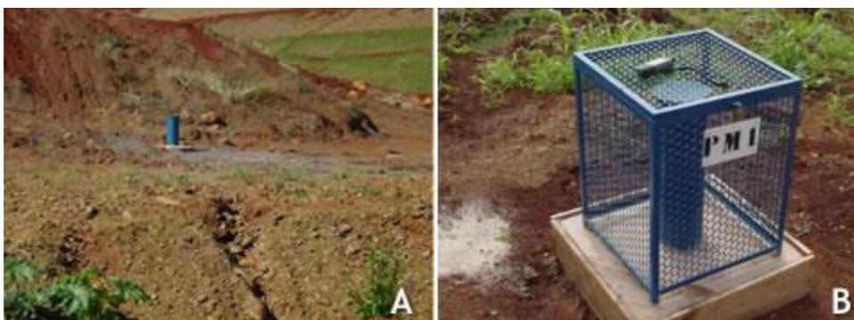
Ilustração dos poços utilizados para monitoramento de recursos hídricos subterrâneos: (a) Poço Tubular Profundo e (b) Poço de Monitoramento.
